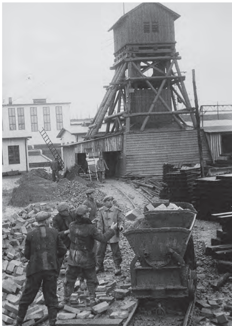
Budowa szybu, robotnicy przymusowi przy pracy (z arch. H.Z.)
